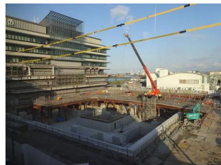
《第2期工事（低層部）工事》
