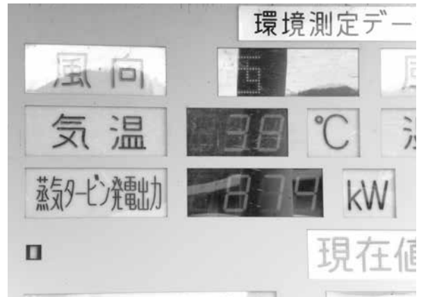
ごみ焼却炉での廃熱利用（グリーンパーク）
