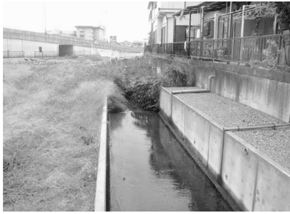
水路改修を施工中の竹田川（金屋地内）
