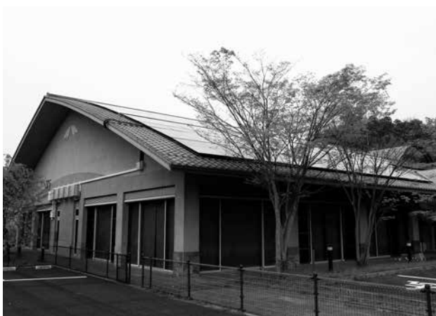
高齢者総合福祉センターの屋根一面に搭載されている太陽光発電システム
