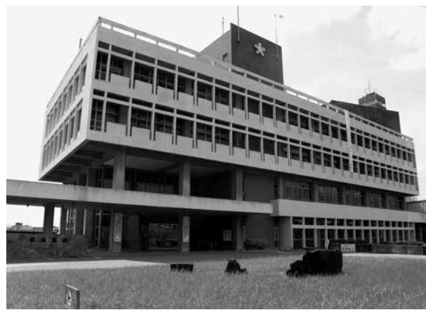
災害時に対策本部が設置されることになる庁舎
