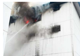
火災発生時の様子▲
