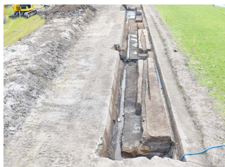
調査区の全景 (北から)▶
