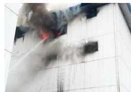
火災発生時の様子▲
