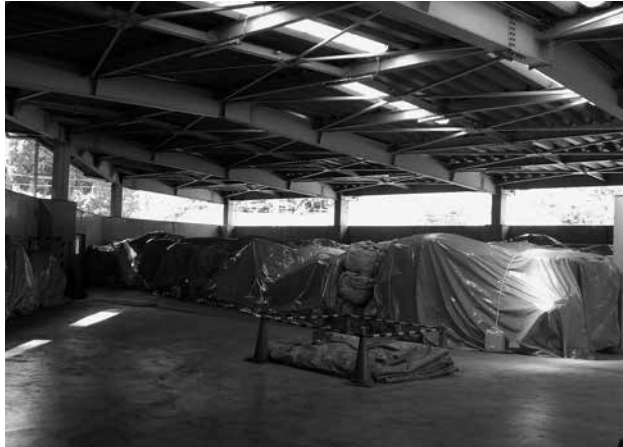
ストックヤードに管理されている処理灰
