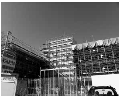
改修が進む子育て支援の拠点（旧桜井総合庁舎）
