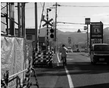
電柱が移設された JR 桜井線貯木場踏切
