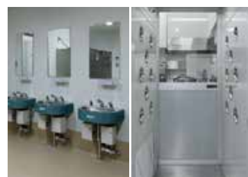
準備室・前室 汚染区域、非汚染区域ごとに設置。手洗いとエアシャワーで衛生管理を徹底しています。
