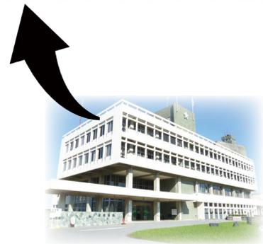
桜井市役所の新庁舎は、現本庁舎建物の西側（これまでの来庁者用駐車場）に、鉄骨造・4階建て・免震構造・延床面積7839.27㎡で建設し、令和3年6月末の完成を目指しています。新庁舎の東側には、新しい駐車場と地域交流広場を設置。駐車場へは国道169号と北側の市道の両方から出入りできます。
