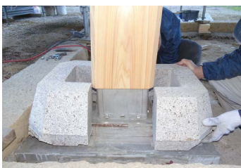
▲ 柱の根元が地面に触れない工法
