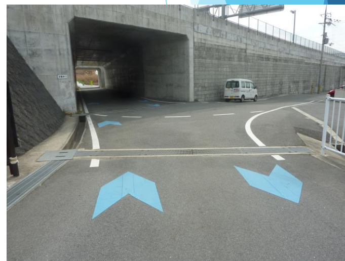
矢羽根型路面標示 (車道混在区間)
