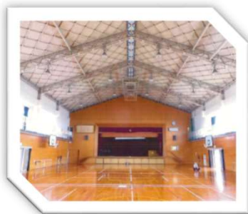
LED照明に更新を行った体育館
