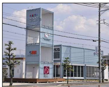
コンテナオフィス
