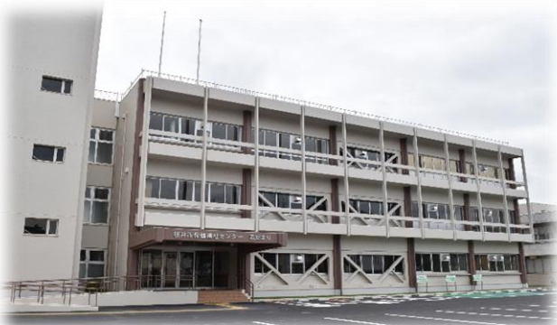
桜井市保健福祉センター陽だまり 外観
