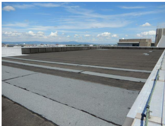
屋上防水の部分補修
