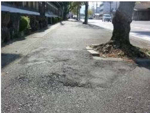
図. 植栽周辺の舗装の凹凸
