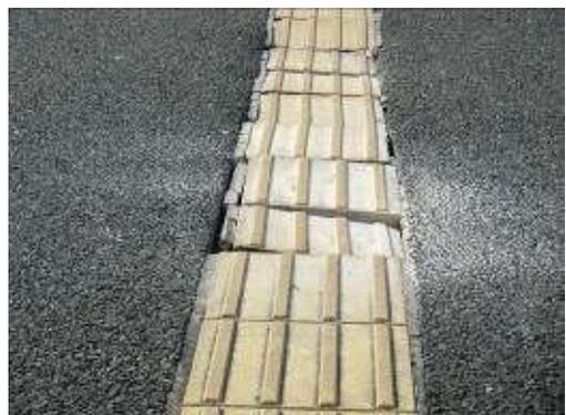
図. 誘導・警告ブロックの陥没
