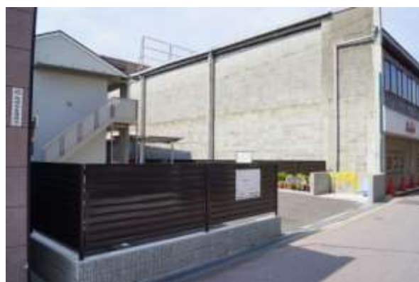
建て替えによるまちなみの変化
