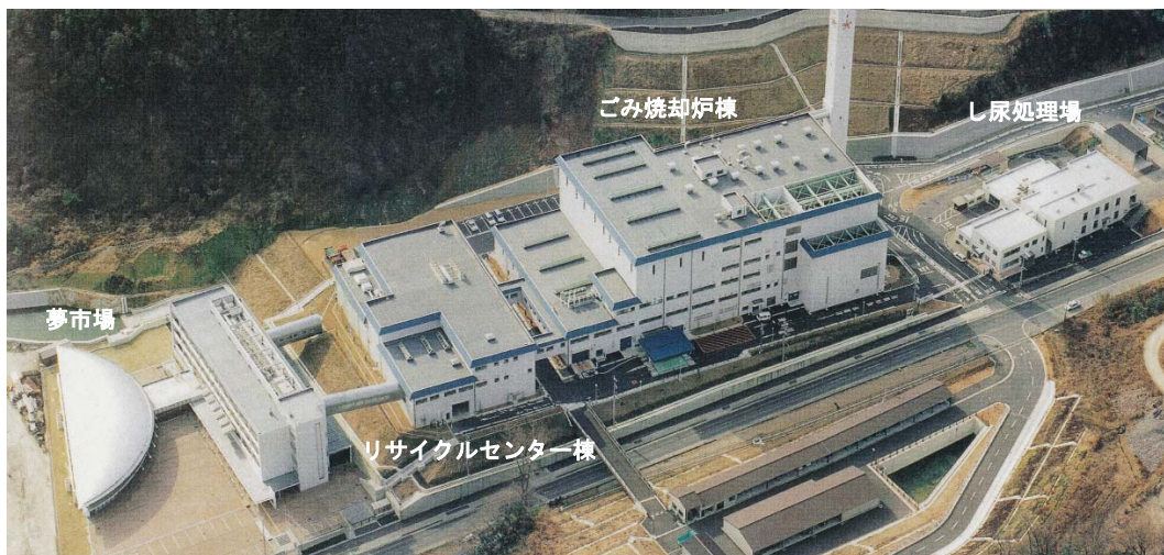
桜井市一般廃棄物循環型社会基盤施設
