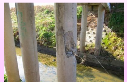
橋脚の損傷（鉄筋露出）
