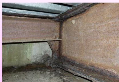
主桁の損傷（腐食）
