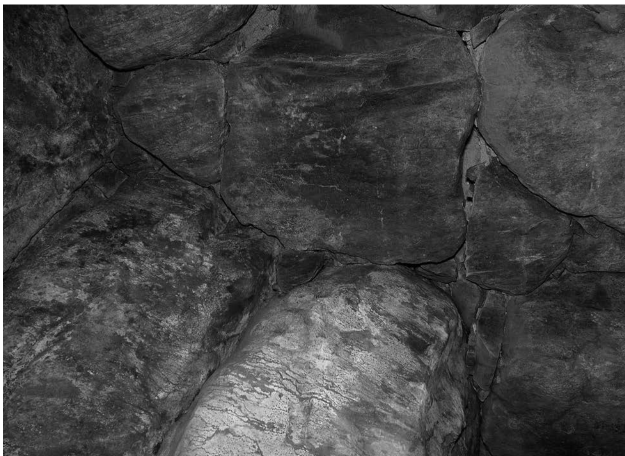
右袖上部の様子 (北東より)
