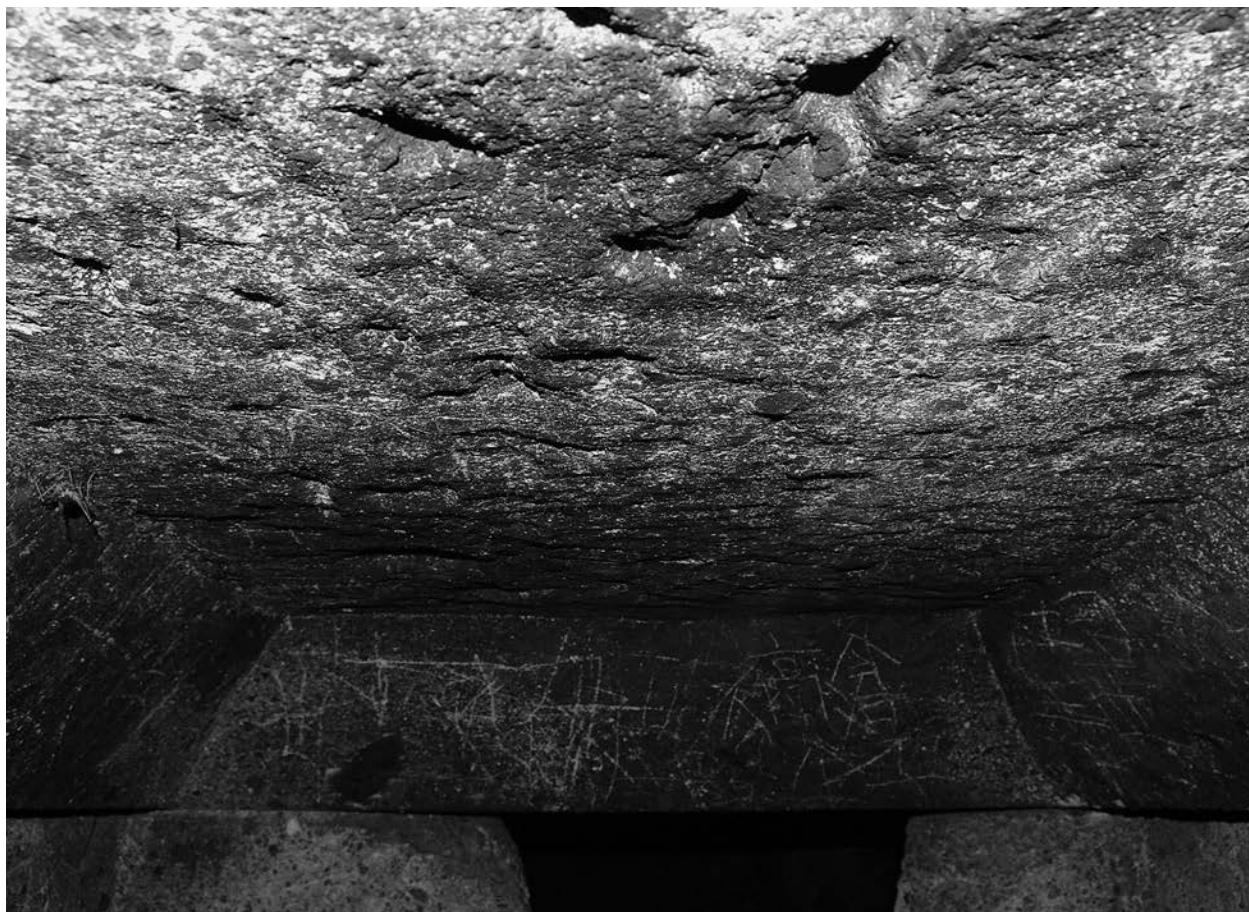
石棺内部南側天井部の工具痕（北より）
