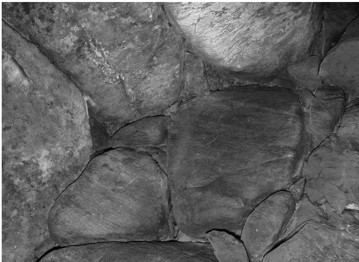
左袖上部の様子(北西より)
