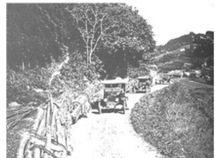
木材運搬風景 (多武峯街道下居付近)
