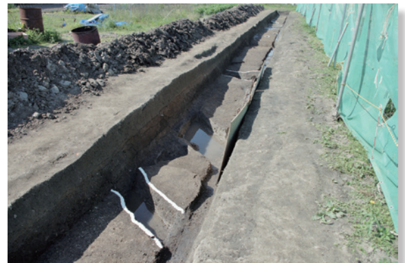
▲遺構完掘状況（南東から）
