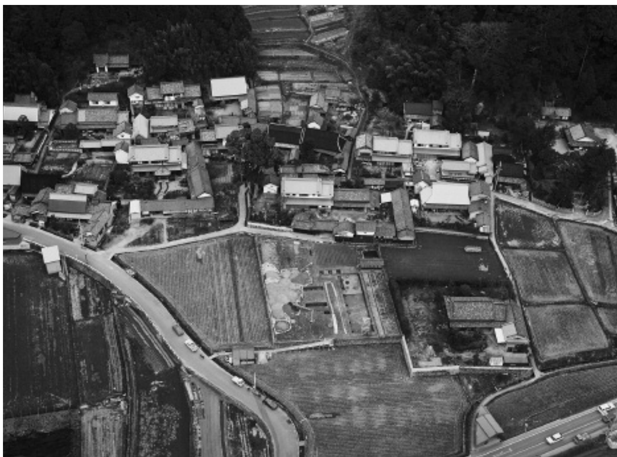
調査区遠景（南上空より）
