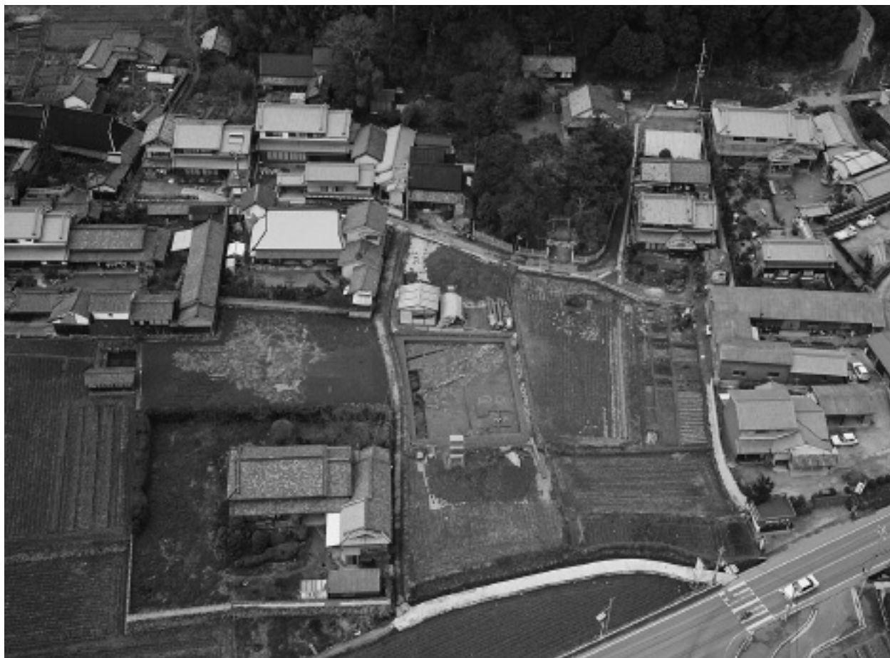
調査区遠景（南上空より）
