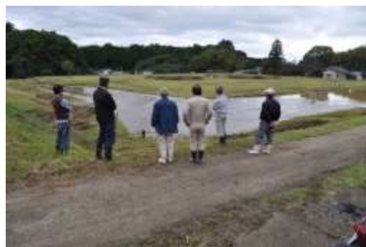
図 5.10 土砂による水路の溢水（平成 29 年）
