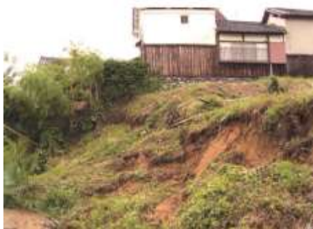
図 5.9 台風による土砂崩れ（平成 19 年）
