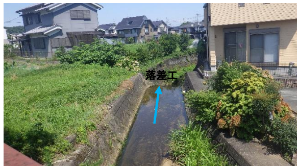
⑥水路下流方向を望む (落差工あり)
