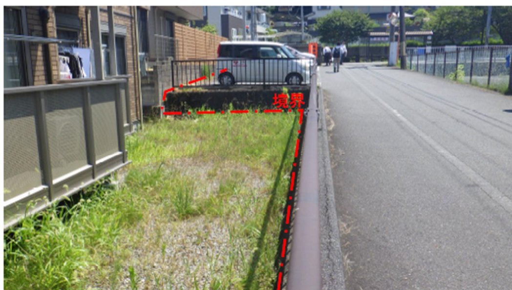
幼稚園入口擁壁
