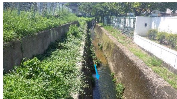
③橋(ボックスカルバート)から上流を望む
