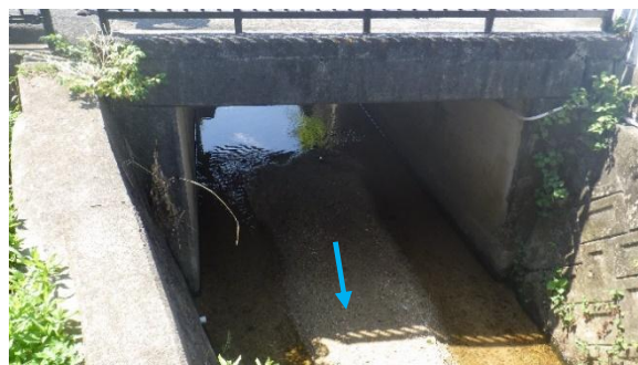
④橋(ボックスカルバート)を望む
