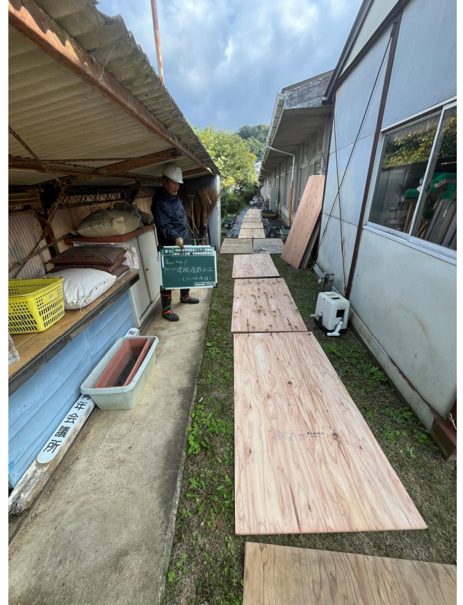
クローラー運搬通路状況 (コンパネ布設)
