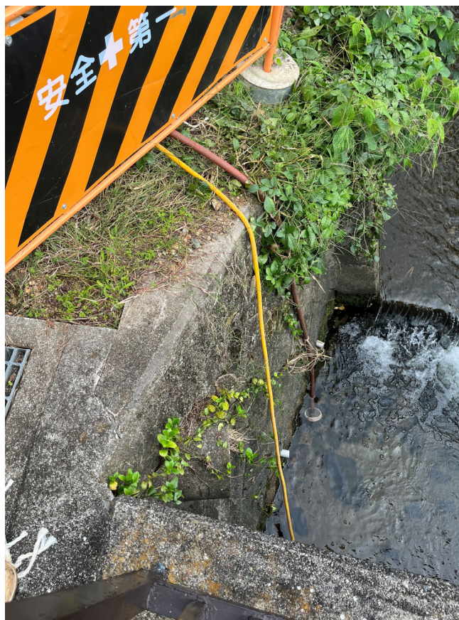
給水仮設状況
