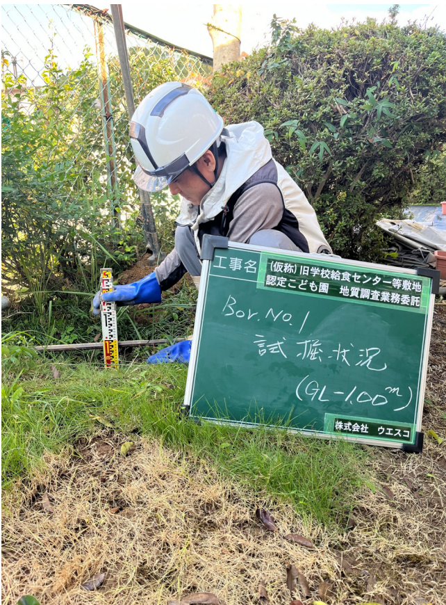
試 掘 状 況 (遠景) (GL-1.00m)
