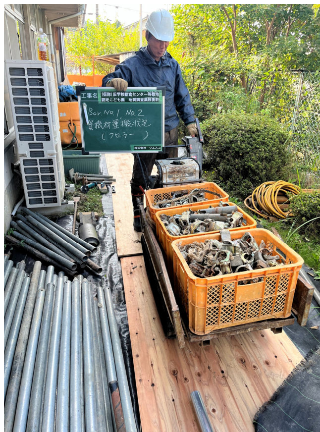
機材運搬・搬入状況 (クローラー)
