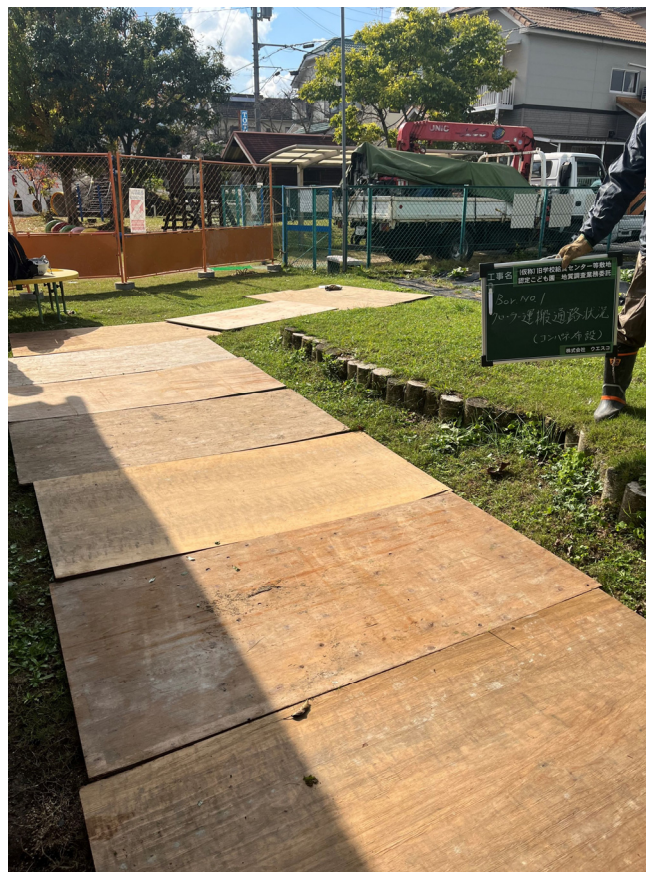
クローラー運搬通路状況 (コンパネ布設)
