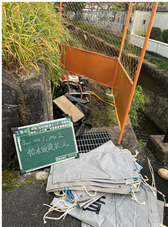
給水仮設状況
