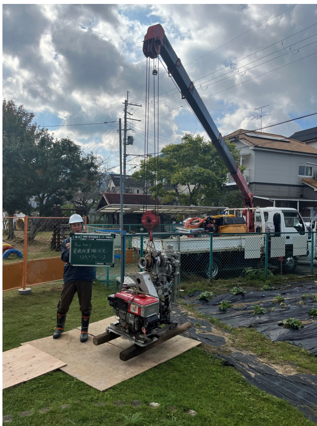
機材運搬・搬入状況 (トラッククレーン)
