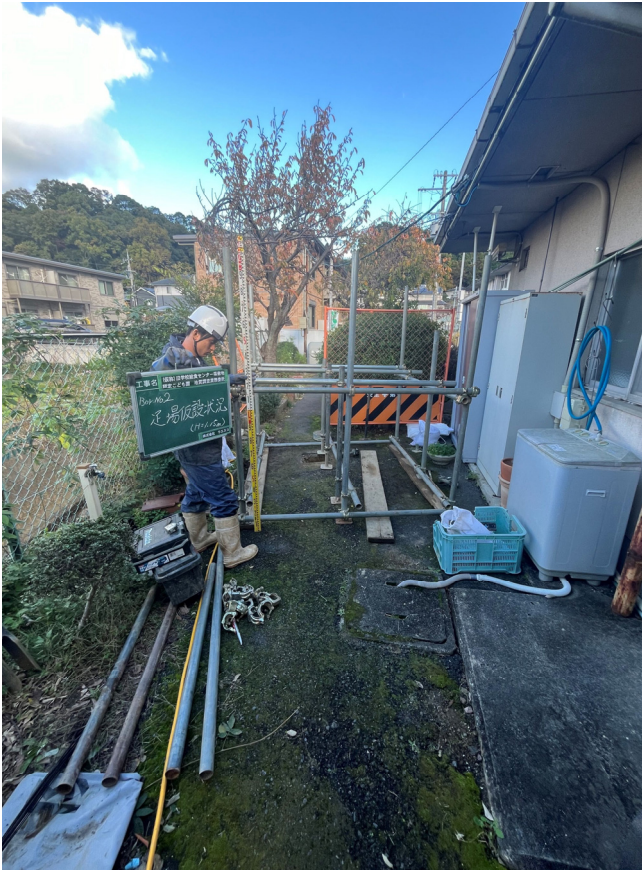
足場仮設状況 (H=1.15m)
