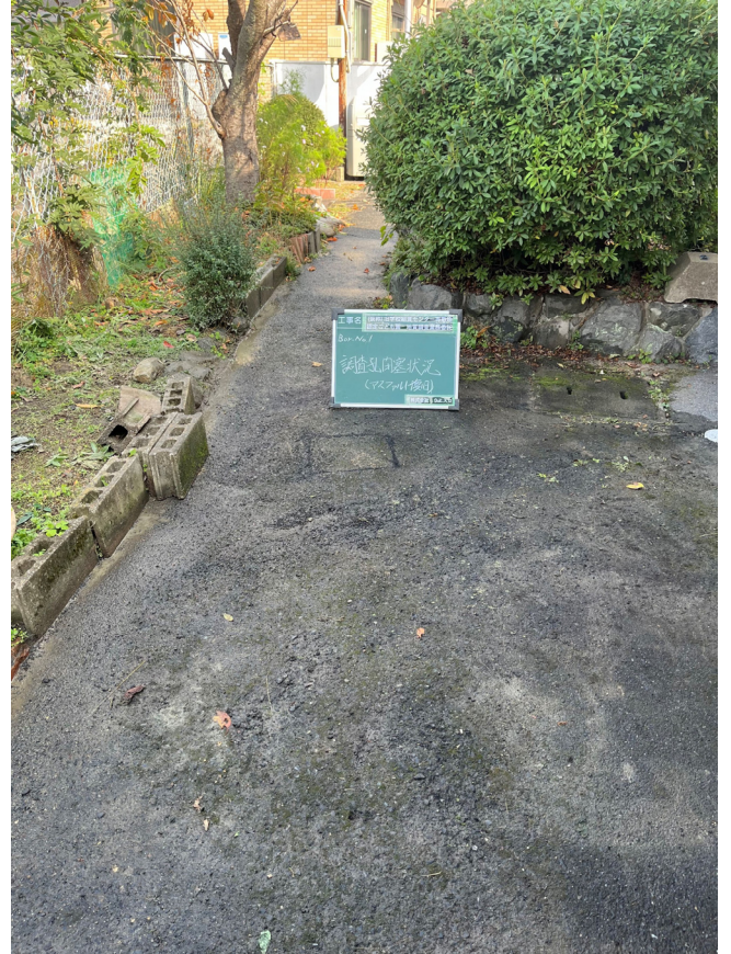
調査孔閉塞状況 (アスファルト復旧)
