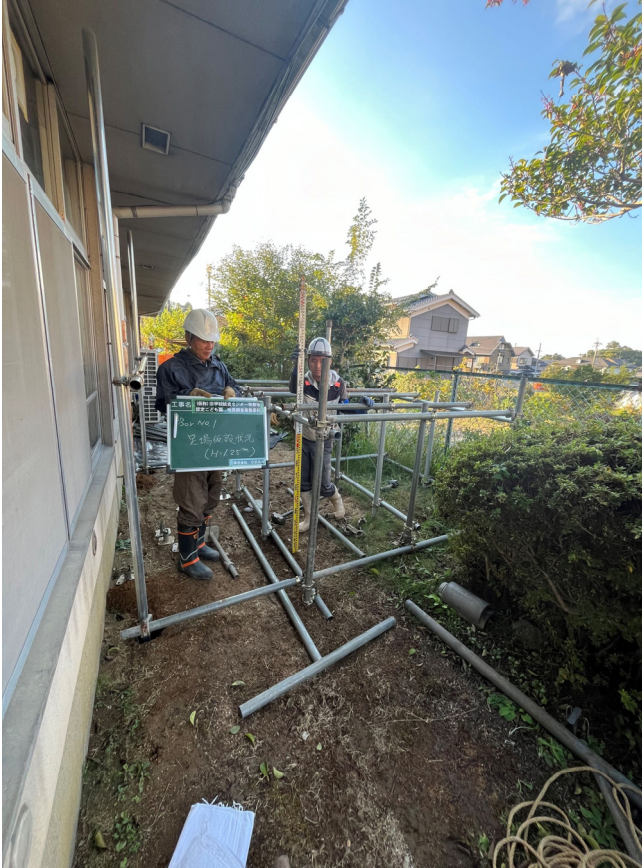
足場仮設状況 (H=1.25m)
