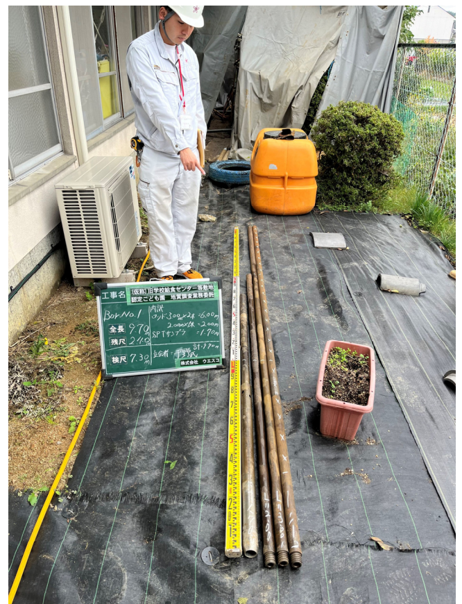
検 尺 (全長9.70m、検尺7.30m)
