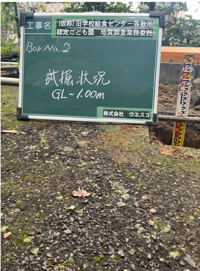
試 掘 状 況 (遠景) (GL-1.00m)
