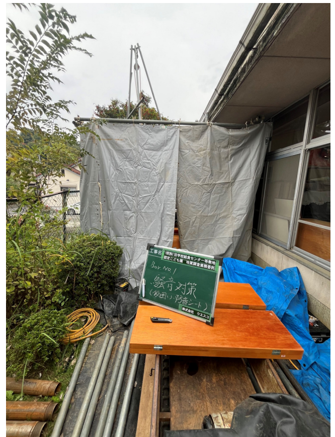
騒音対策 (仮囲い・防音シート)
