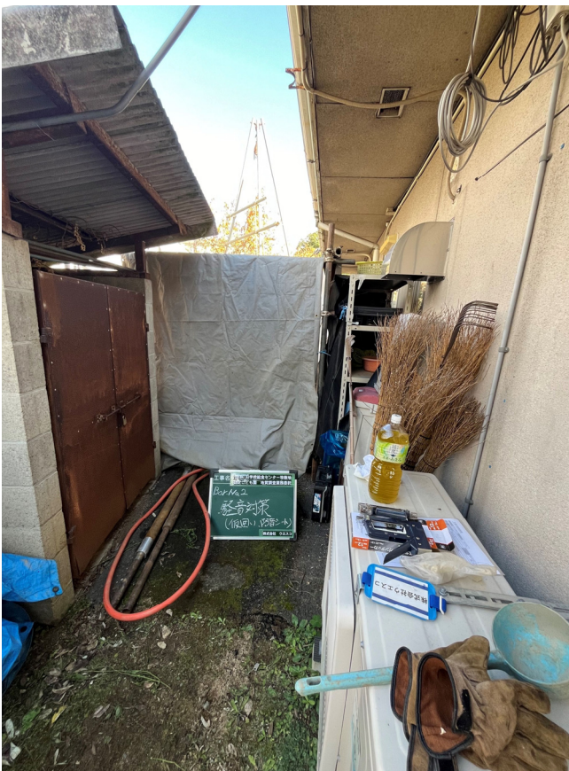
騒 音 対 策 (仮囲い・防音シート)
