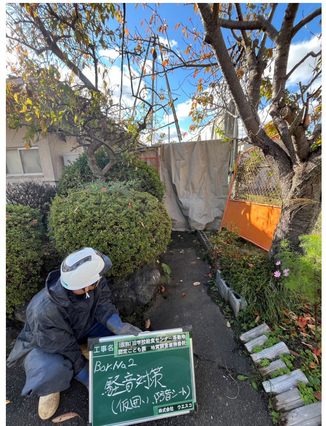
騒 音 対 策 (仮囲い・防音シート)
