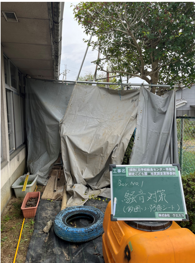
騒音対策 (仮囲い・防音シート)
