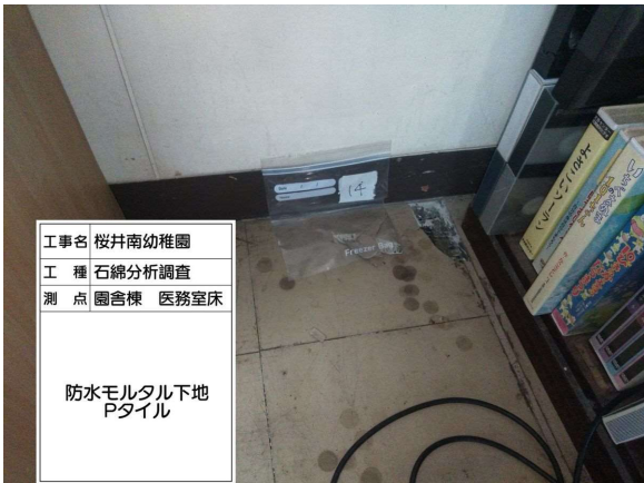
工事名 桜井南幼稚園 工 種 石綿分析調査 測 点 園舎棟 医務室床 防水モルタル下地 Pタイル
