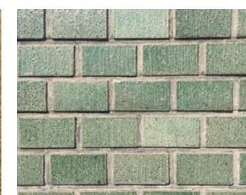
写真⑯ 外壁タイル
