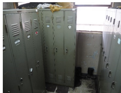
■狭隘なロッカースペース
